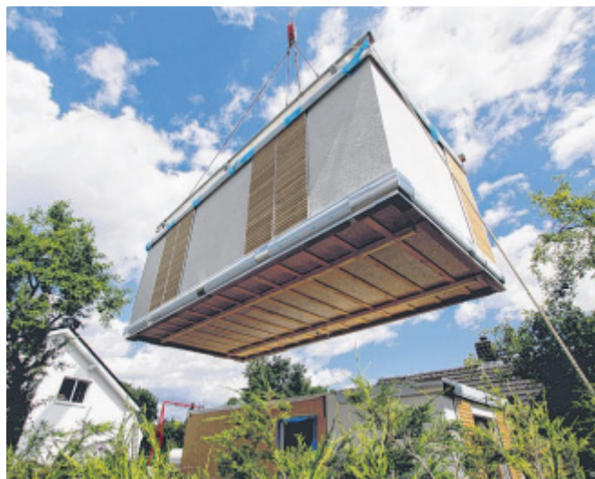
So wird das Fertighaus angeliefert: Mit einem Kran wird das Smart-House-Modul auf ein weiteres gesetzt.
