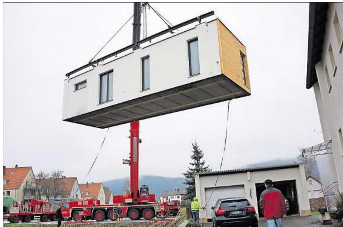
Ein 210-Tonnen-Kran mit 35 Meter Auslegerlänge war notwendig, um die beiden Haus-Module in Neuses an Ort und Stelle zu platzieren. Bei Bedarf kann das Heim auch wieder abtransportiert und woanders neu aufgestellt werden.
